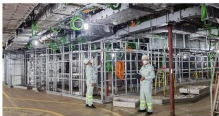
华南建材项目施工现场
